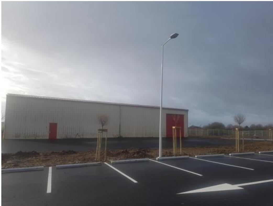
Mât d'éclairage face au hangar de stockage
